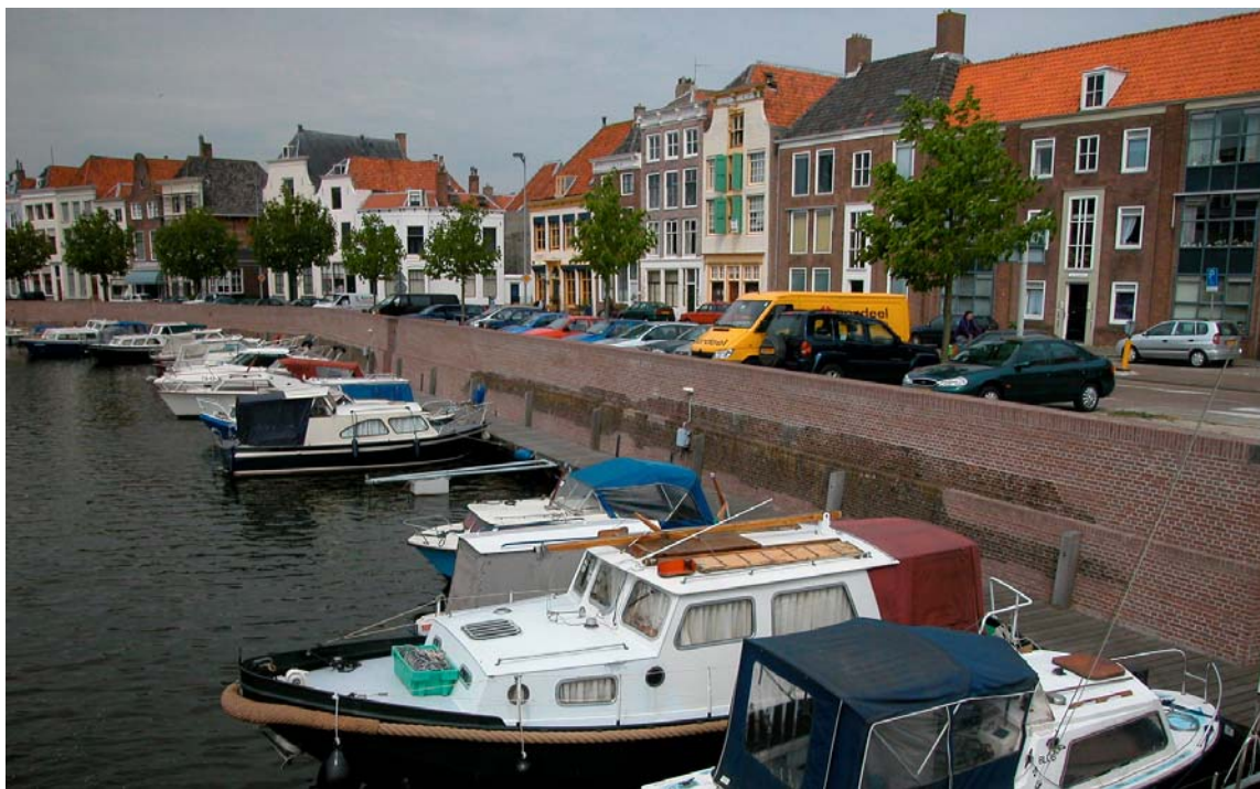
De Dam met ingrijpend vernieuwde kademuren.
