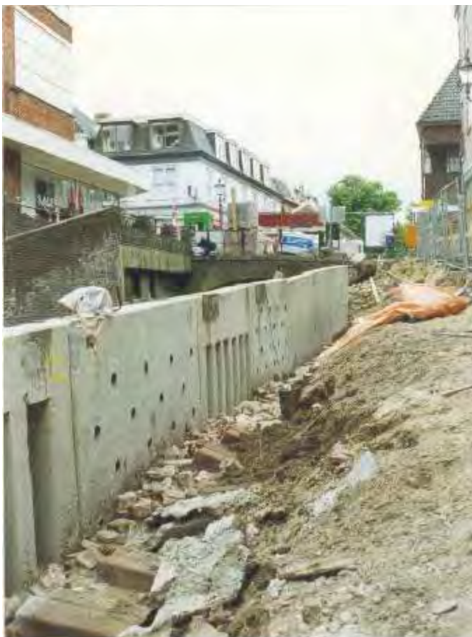
Experiment met betonnen grachtenmuur in Amersfoort. In het beton zijn verschillende uitsparingen opengelaten om vocht toe te laten. Planten kunnen zich hier spontaan vestigen.
