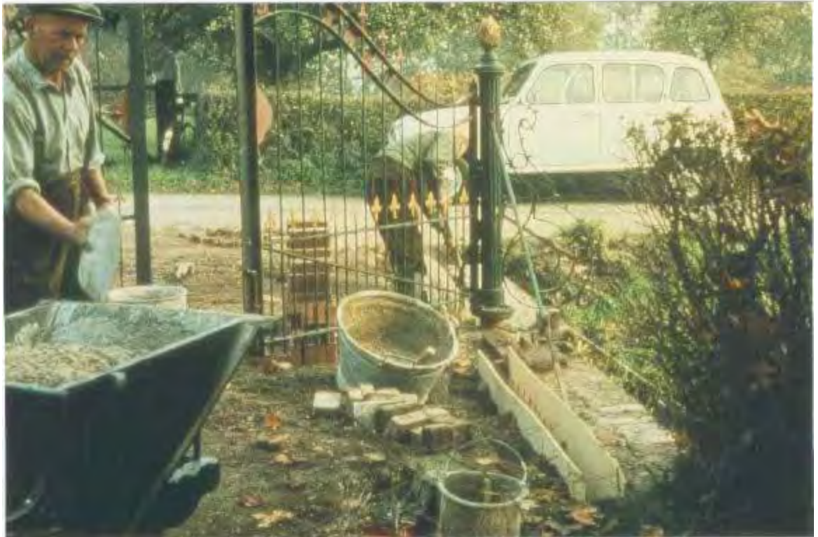
Boerderijdam te Baambrugge (provincie Utrecht), werkzaamheden bij de restauratie in 1964.
