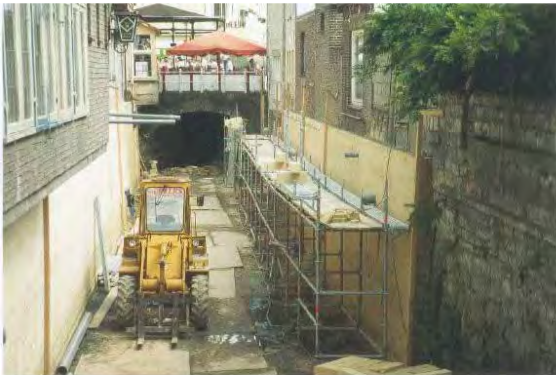
Valkenburg, voorzetwanden van nieuwe mergelstenen worden aangebracht ten koste van wettelijk beschermde soorten als Stengelomvattend havikskruid en Blaasvaren.
