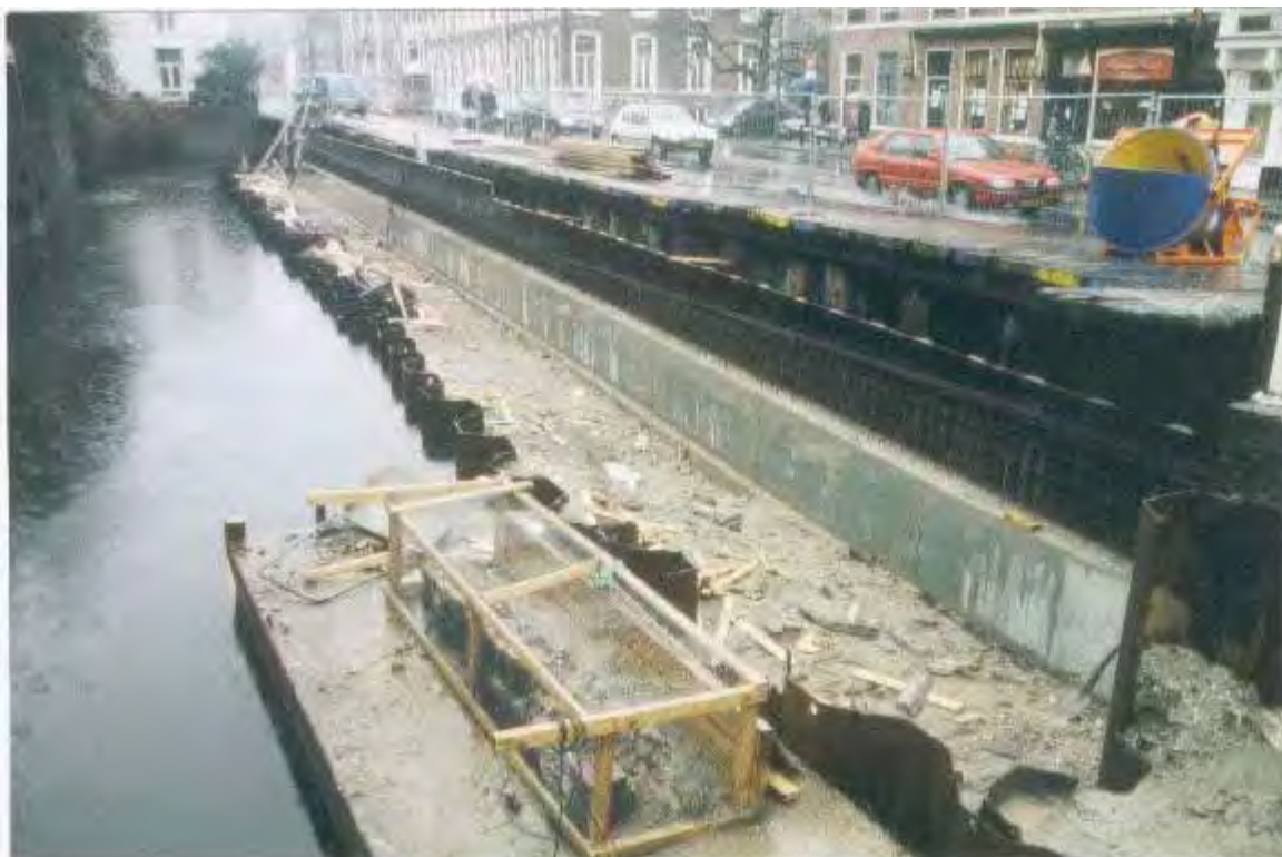
Mauritskade in Den Haag. Transplantatie van Steenbreekvarens in de kademuur. Pakketjes met varens zijn tijdelijk terzijde gelegd en met gaas afgeschermd.
