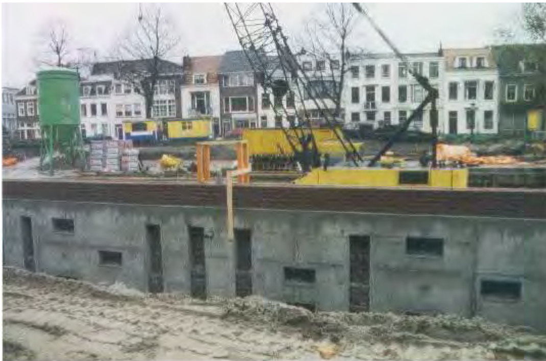
Idem, betonnen wand met uitsparingen om vocht door te laten.
