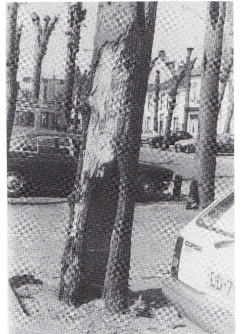
Detail van de Markt in Etten met als gevolg van het parkeren onherstelbaar beschadigde lindestammen.
