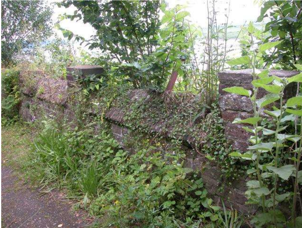
Muurbegroeiing met o.a. Muurleeuwenbek op de vroeg 18 e eeuwse, mogelijk nog 17 e eeuwse, in kalkspecie gemetselde tuinmuur.
