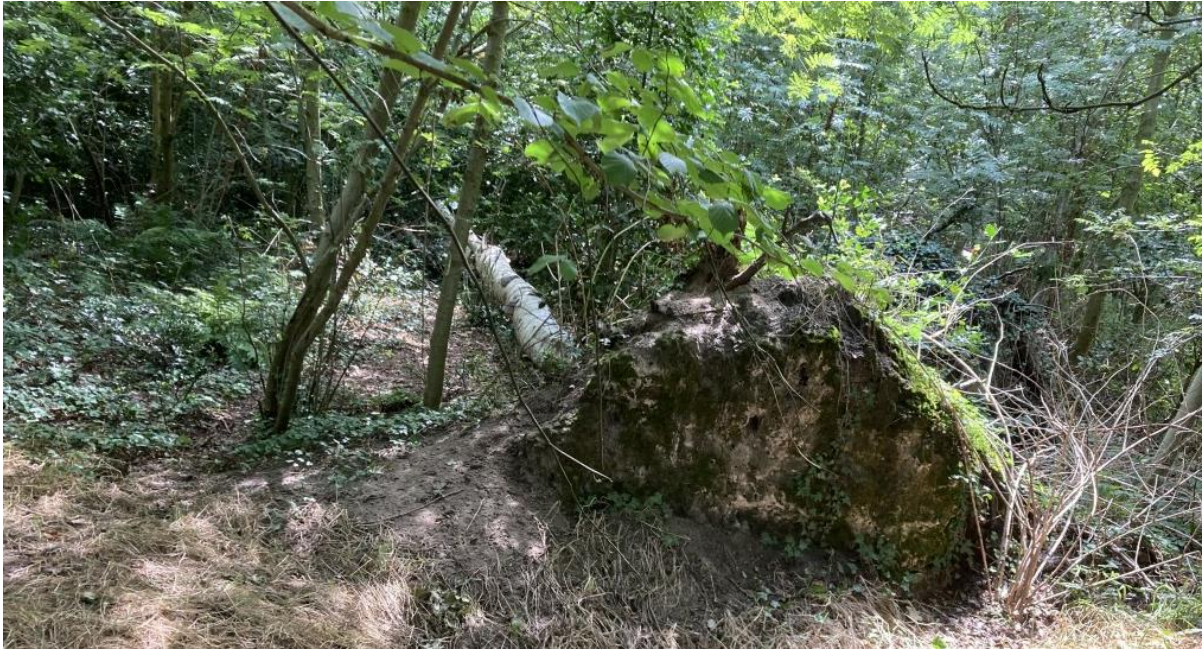
38. Dode bomen op wallen die omvallen kunnen schade toebrengen aan het wallichaam. Opname 23092001.
