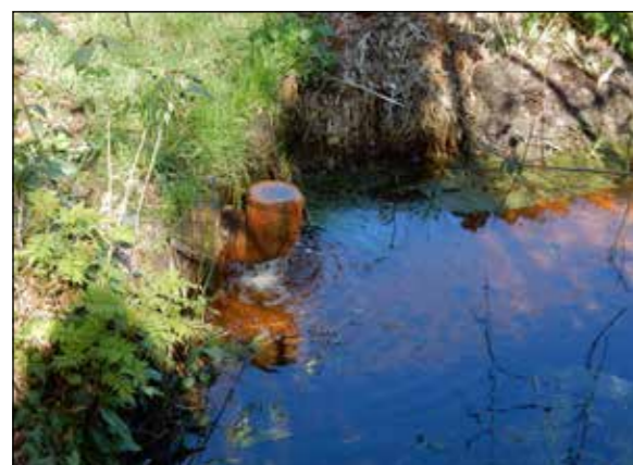
De afvoer van de drainage vanuit de woonwijk loost nu op de sloot langs de Noorderweg.
